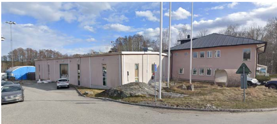
Figur 6. Kontors- och fabriksbyggnad inom Flygkompassen 1. Till vänster syns ett blått tält inom Höjdmätaren 1.
